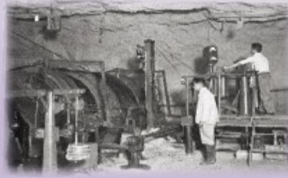
坑内 竖坑巻上げ機
